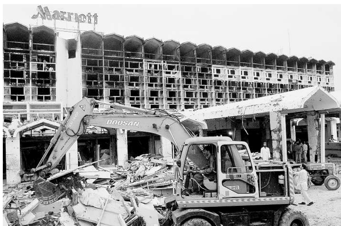
HOTEL MARRIOTT Nella foto i gravi danni subiti dall'edificio a causa dell'attentato.
